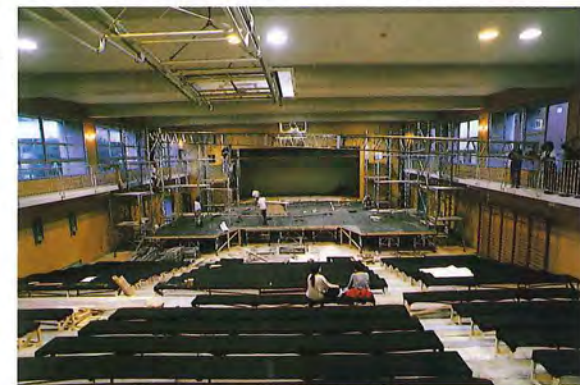
10月8日。客度は組み上がり、ステージの建て込みも進む。
