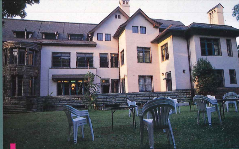
広大な中庭から臨む建物全景。3階左側が今回の会場となった。 【補注】この建物は一般公演には使用できないことになっています
