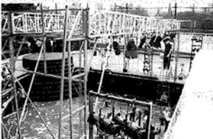
照明吊り込み。周辺部分をも照らす必要から、屋内以上に照明はたくさん必要。今回用意した照明はおよそ100個以上。照明協力(株)シアタークリエイション
