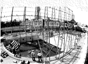
鉄骨組み。照明を吊ったり雨よけのシートを張るため、プールの両サイドに鉄骨を組む。左右の幅は約17メートル。ちなみに写真中央に見えるのは東京タワー。
