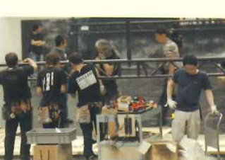
【パネル吊り込み1】 背景の描き込まれたパネルをバトンにくくりつけていく。
