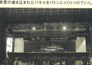
【パネル吊り込み2】 劇場にはバトンが全部で約50本。どのバトンに何のパネルを吊るか、「バトン割り」の仕組み図が欠かせない。
